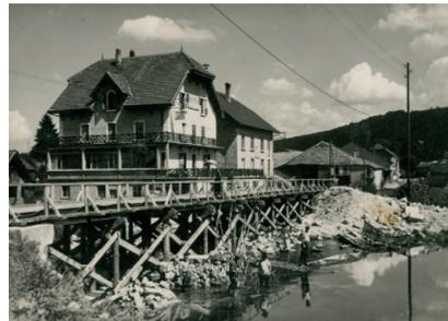
*Pont provisoire suite au bombardement du pont en 1940*
